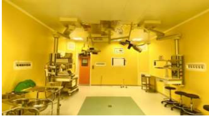
Gambar 2.6. Kamar operasi bedah digestif RSUD Arifin Achmad Provinsi Riau Sumber: IBS (2022)
